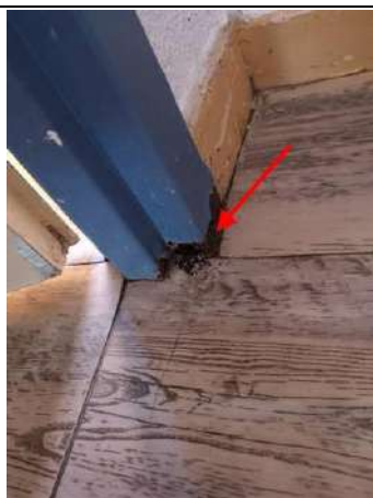
Photo n° PhTer001 Localisation : Wc Ouvrage : Huisseries porte
