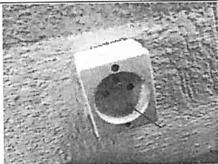
Photo PhEle001 Localisation : Général Libellé de l'anomalie : B3.3.6 a2 Au moins un socle de prise de courant comporte une broche de terre non reliée à la terre. Remarques : (1er étage - Véranda 3)
